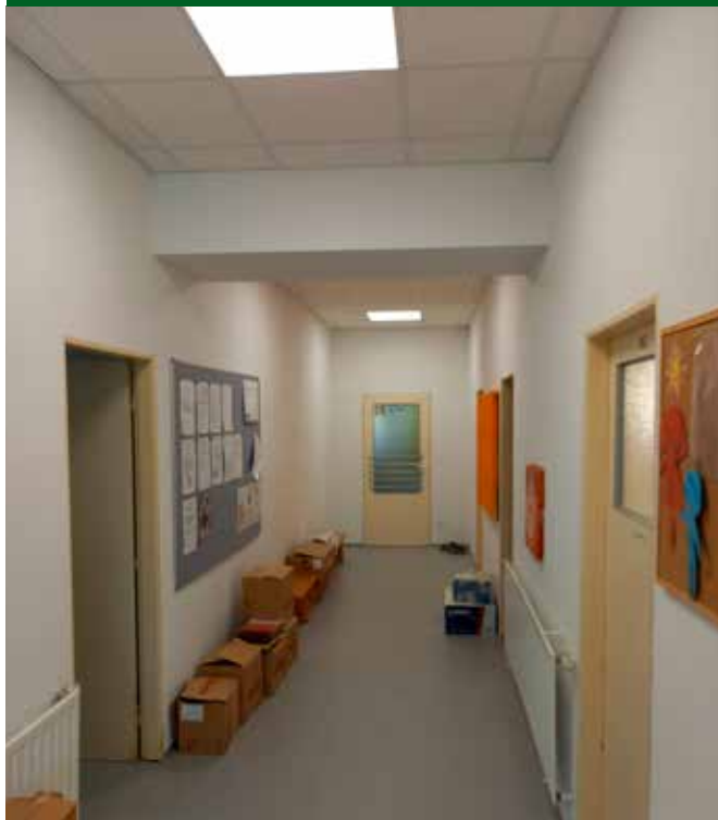
Rekonstrukce elektroinstalace mateřské školy a kuchyně ve Vrbátkách
